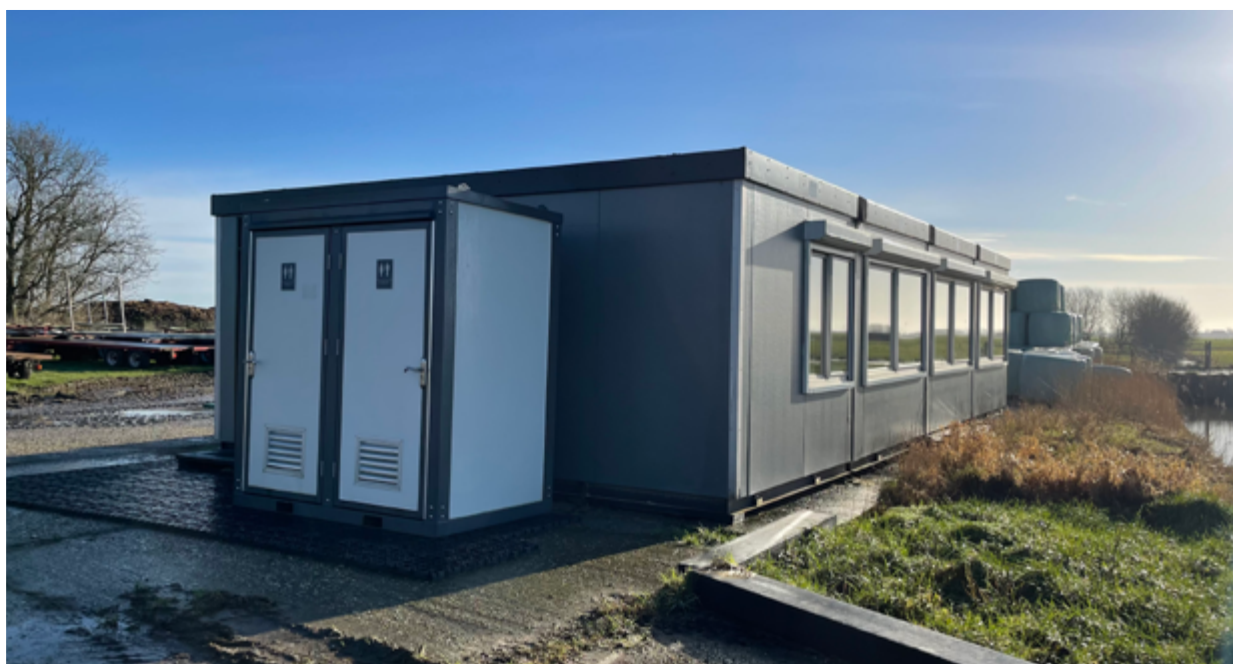
Bezoekerscentrum ANF in aanbouw.
